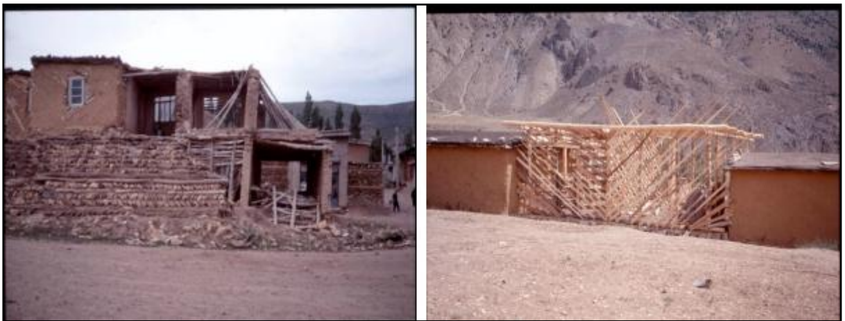
Figure 4 : « Iran, à gauche maison traditionnelle à vulnérabilité élevée, à droite tentative locale de diminuer la vulnérabilité »
