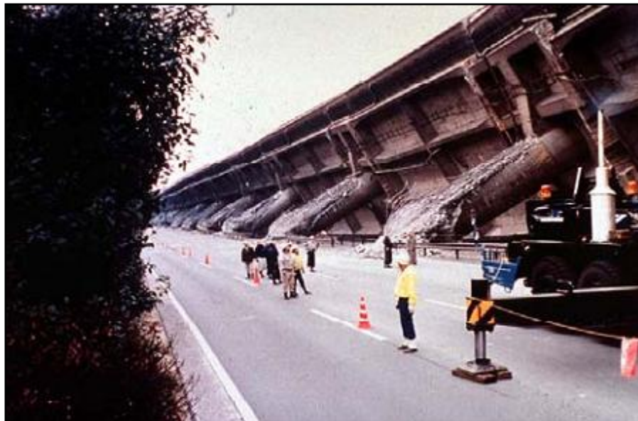
Figure 6 : « la ruine d'un pont lors du séisme de Kobé par effet de pendule inversé »
