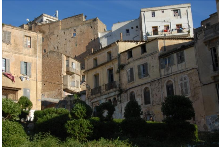
Figure 4.6 : Immeubles dégradés de la Calère.
